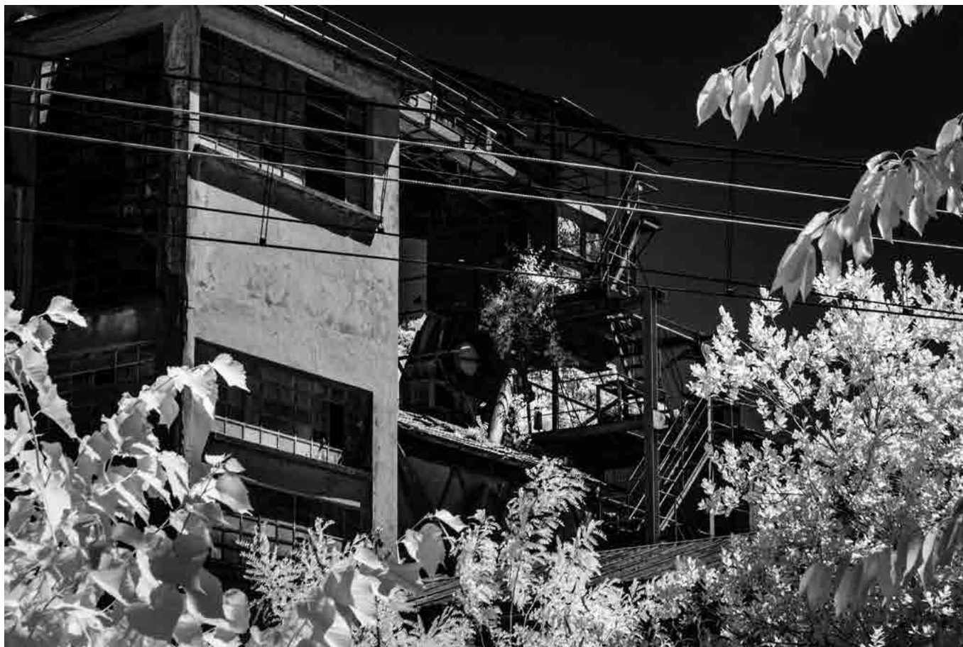
Impianto di macinazione
