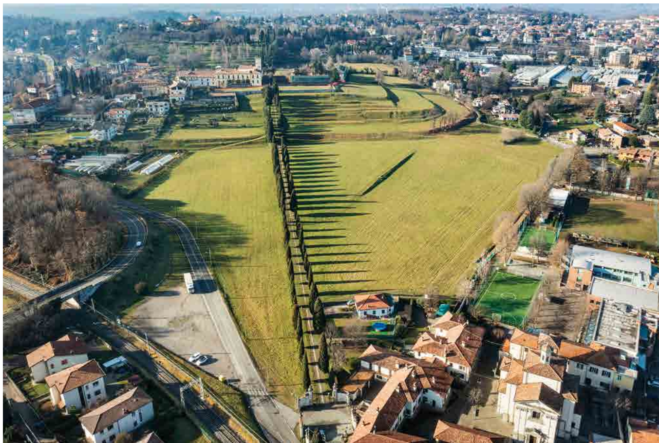
Accerchiamento edilizio del Viale dei Cipressi, Inverigo (CO).
