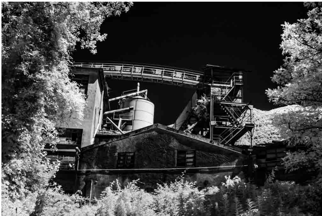
Condotte aeree interne
