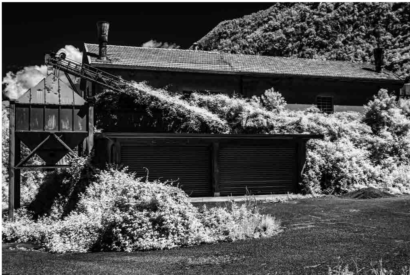
Magazzino di caricamento
